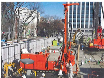
地中熱探熱孔掘削
