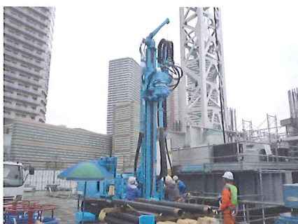
地中熱探熱孔掘削
