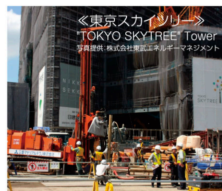
《東京スカイツリー》 "TOKYO SKYTREE" Tower 写真提供:株式会社東武エネルギーマネジメント 地中熱を利用した熱交換井 (SD-200) Geothermal heat-exchange well
