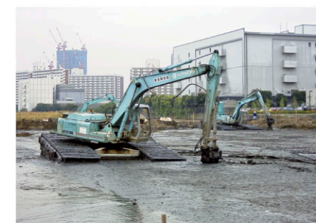
軟弱表層改良工法 Loose surface layer improvement
