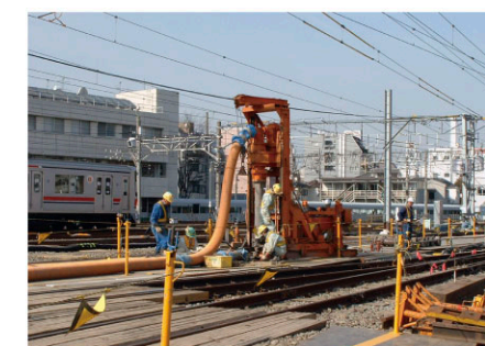
基礎杭機 (TBH) Foundation pile drill
