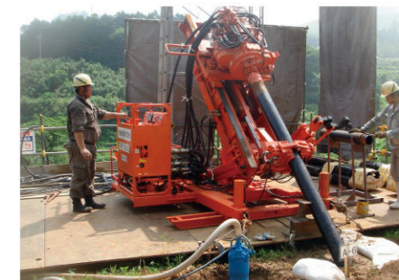
アンカーによる地すべり対策 Anchoring for land slide prevention
