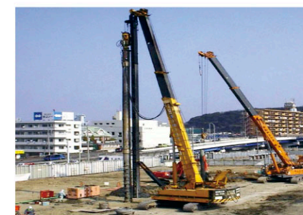
既設コンクリート杭の撤去 Removal of existing PC pile
