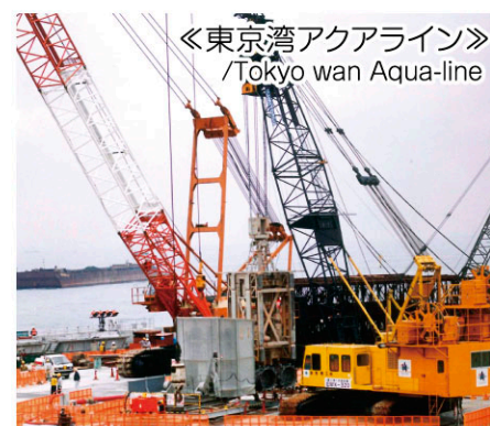
《東京湾アクアライン》 /Tokyo wan Aqua-line 海上での遮水壁構築(EMX) Diaphragm wall construction for cut-off wall
