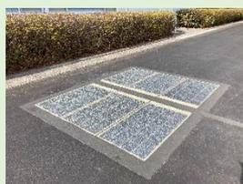
・フランスの Colas 社とフランスの国立太陽エネルギー技術研究所（CEA-INES）が共同して開発した太陽光発電舗装システム。パネル表面に施されたすべり止め加工により、歩行者や自動車の通行を可能にした太陽光パネルで、脱炭素化や空間の利活用に有効な再生可能エネルギー設備。
